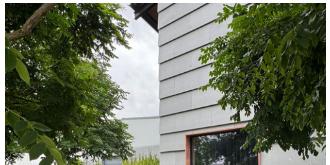
overlappende panelen waardoor bevestigingen onzichtbaar worden
